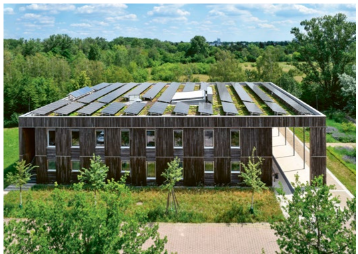
4 Solaranlage auf extensiv begrüntem Flachdach.
