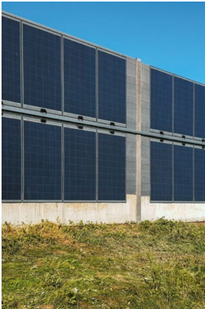
Solaranlage an der Aussenseite einer Lärmschutzwand.
