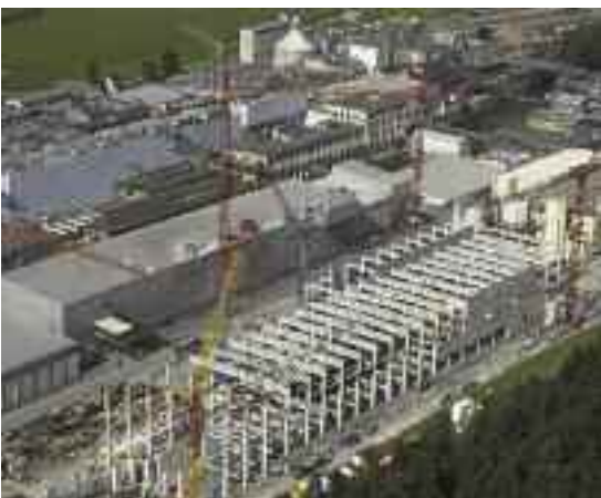
Rohbau für die neue Papiermaschine der Papierfabrik Perlen.
